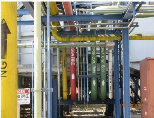
ภาพที่ 2-32 ทิศทางการไหลของระบบท่อ
