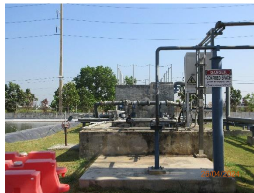
ภาพที่ 2-11 Oil Separator
