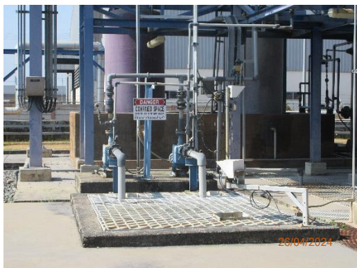
ภาพที่ 2-10 Neutralization Tank
