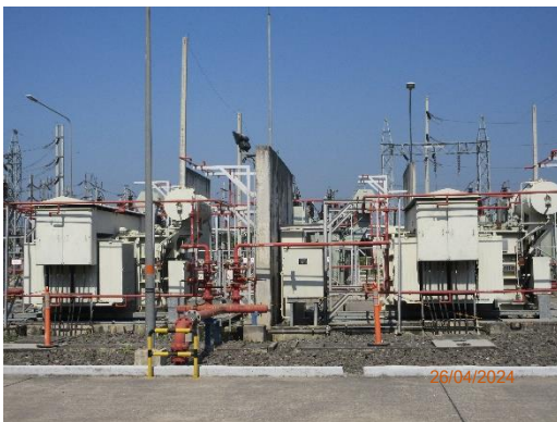
ภาพที่ 2-38 Sprinkler System
