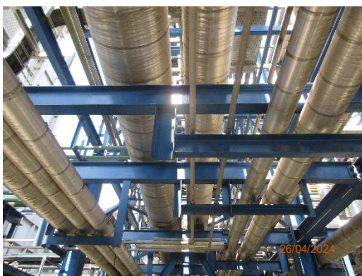
ภาพที่ 2-23 ระบบฉนวนป้องกันความร้อน
