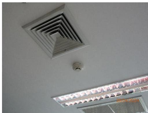
ภาพที่ 2-36 Smoke Detector
