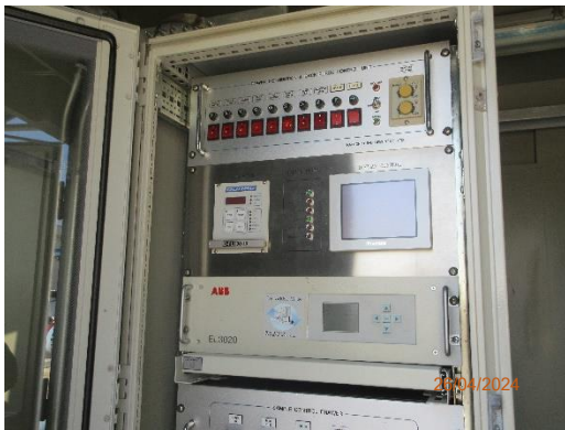
ภาพที่ 2-1 ระบบตรวจสอบคุณภาพอากาศแบบต่อเนื่อง (CEMs)
